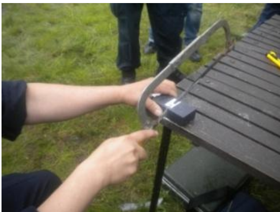
Сл. 19. Припрема пуњења – сечење експлозива
