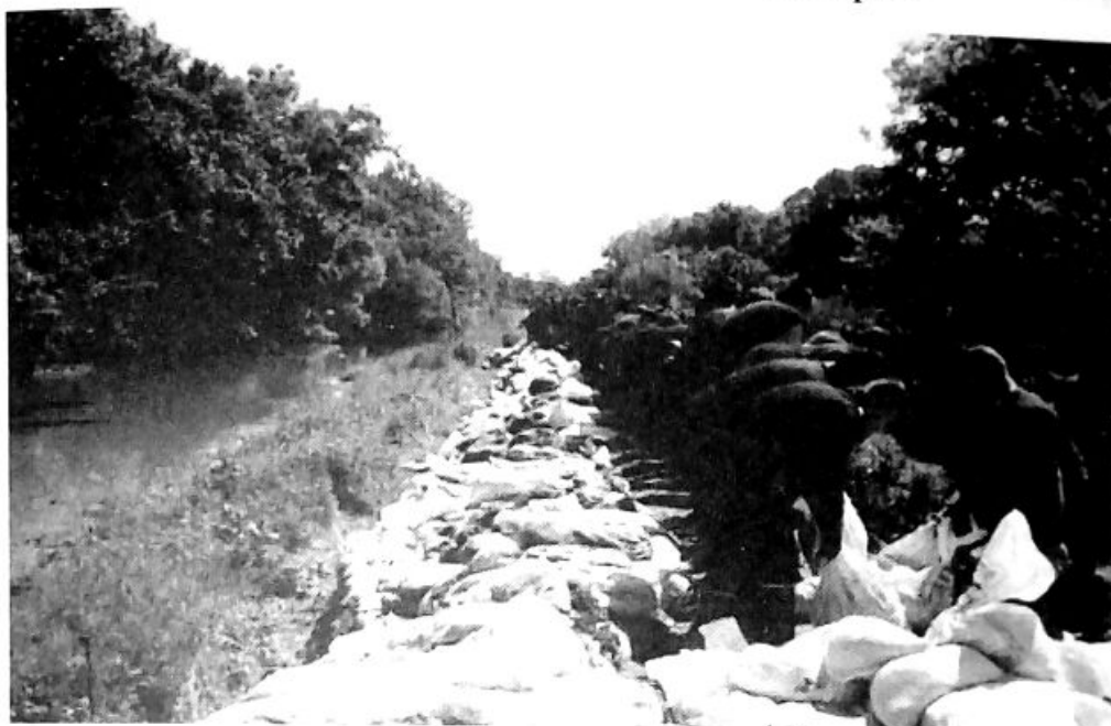
Slika 4. – Angažovanje združenih snaga Direkcije policije na utvrđivanju nasipa uzvodno od Šapca (Izvor: Foto arhiva KPA )
