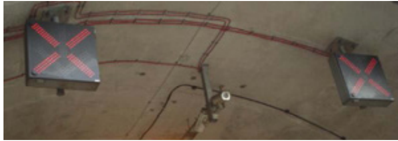
Слика 7: Измењива ЛЕД сигнализација и видео камење на стационажи портала
