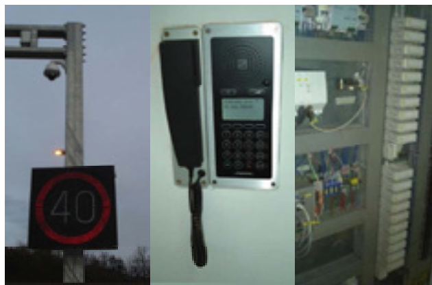
Слика 8: Делови система – ЛЕД знак, Интефон, управљачки контролер
