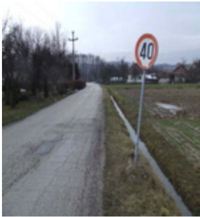
Слика 2. Неадекватно постављена саобраћајна сигнализација
